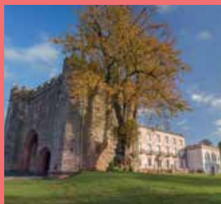
Abaty Torre: Atgyweiriadau brys
